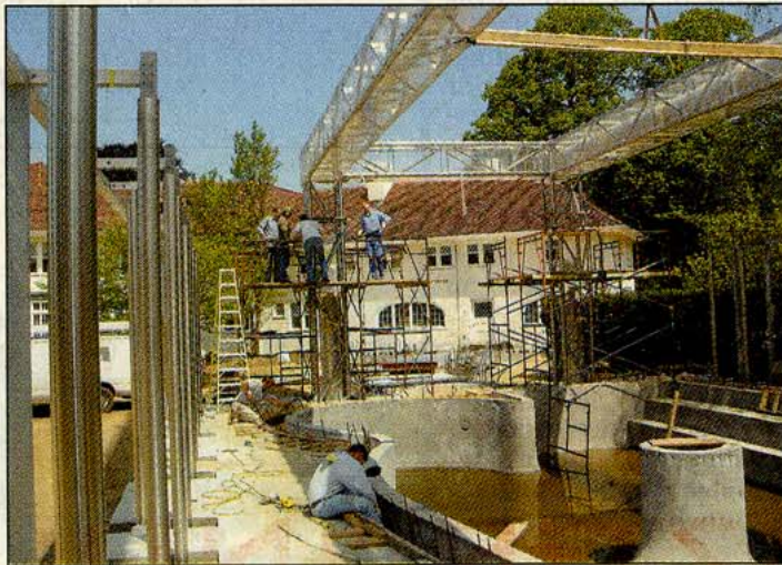
Auf Long Island bei New York baut das Lüdinghauser Unternehmen derzeit ein exklusives „Poolhouse“.
